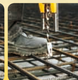
4 Тянуть дальше вплоть до точки автоматического разъединения: соединение затянется.
