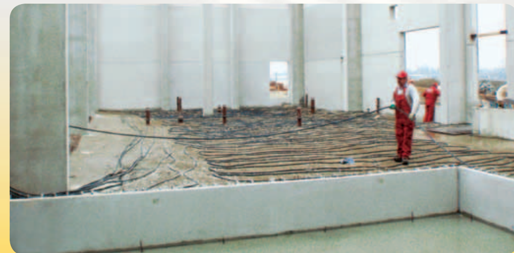
Устройство для прогрева почвы NSH 700 доводит бетон до его идеальной температуры затвердевания 18 °C - 24 °C, экономя при этом время и деньги.
